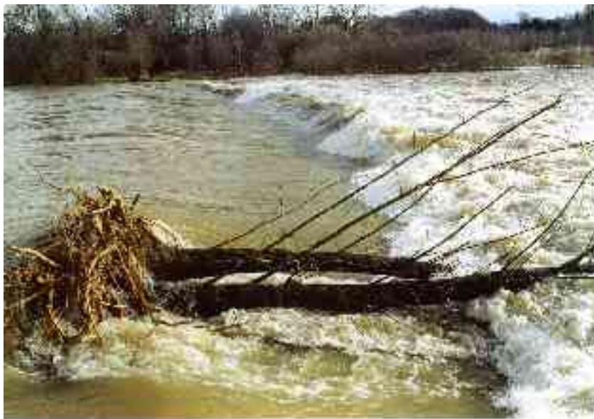
Bild 2: Durch Hochwasser ist ein Totholzstamm an einer Wehrkrone hängen geblieben und muss beseitigt werden.
